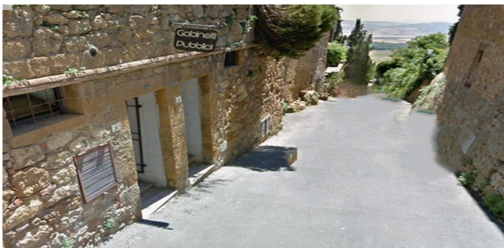
66 servizi igienici non accessibili
