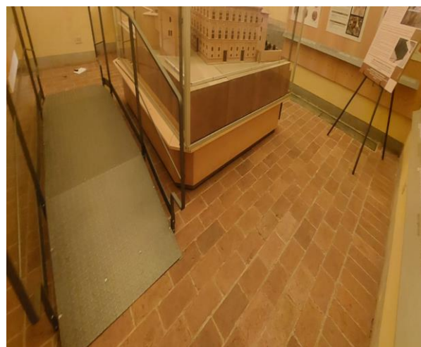
53 rampe metalliche interne
