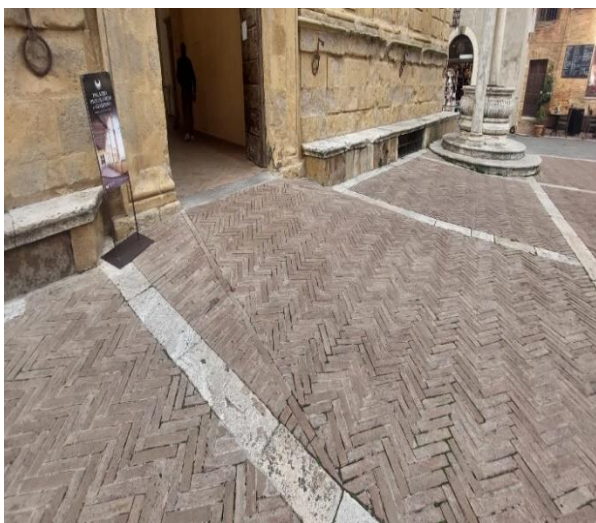
25 rampa di accesso
